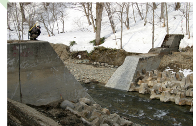
魚が通れるようV字カットされた落差工。北海道標津町の忠類川水系イケシヨマナイ川で、2009年4月撮影。
